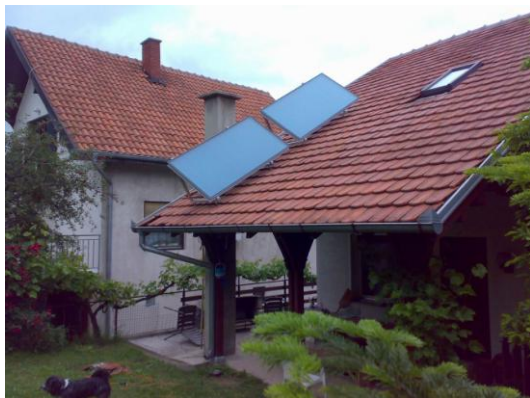
Илустрација: Плочасти соларни колектор уграђени на кровове
