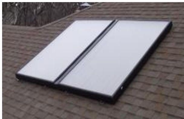
Илустрација: Плочасти соларни колектор уграђени на кровове
