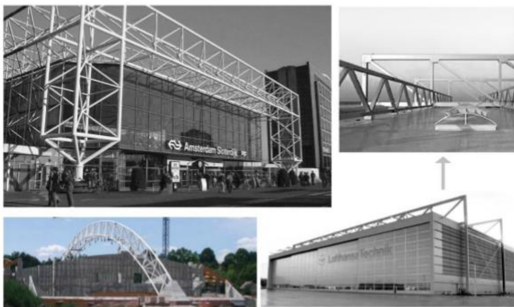
Слика 2.31- Примена решеткастих носача од шупљих профила [3]
