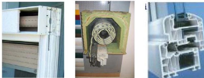
Слика 2.2: Изолавање кутија ролетни и вишекоморни прозорски профили
