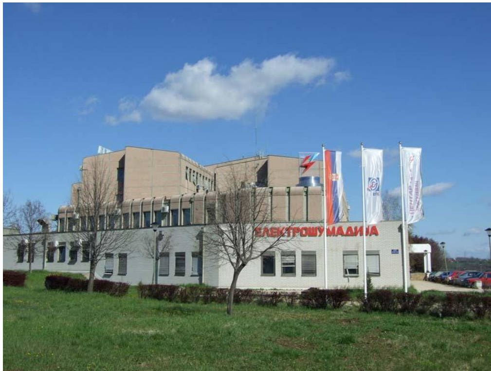
Слика 5. Огранак „Електрошумадија“ Крагујевац
