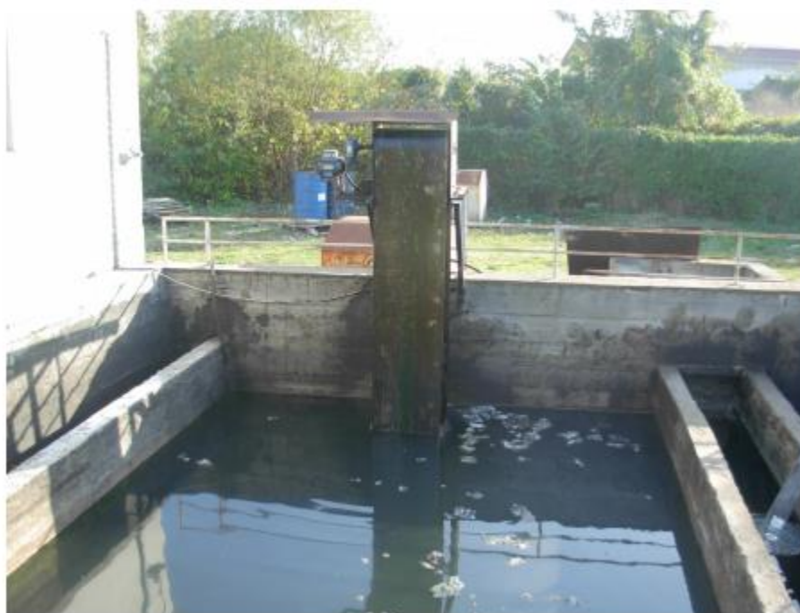
Слика 10.2.1. Аутоматски тракасти скидач уља
