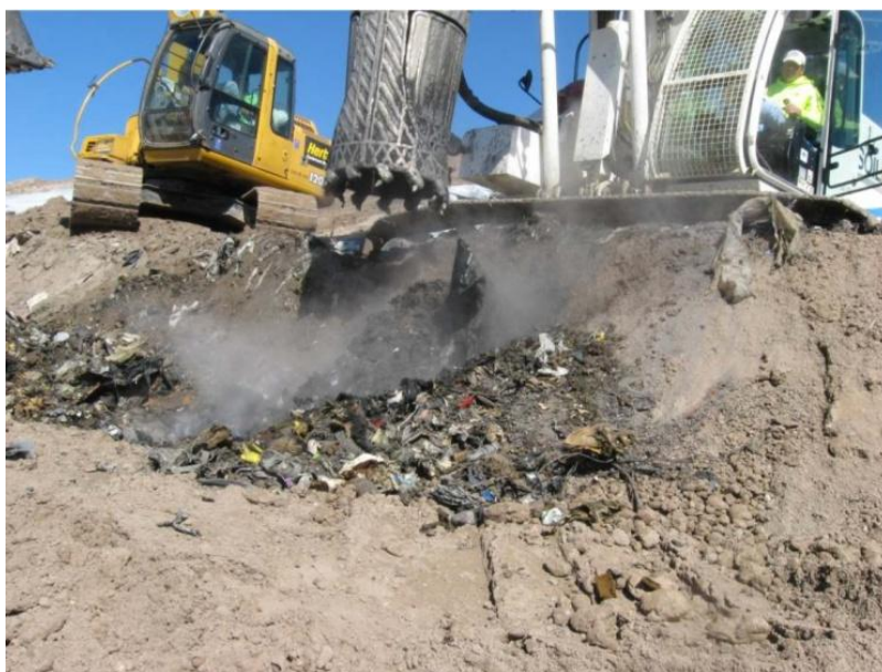
Slika 32. Bušenje bunara
