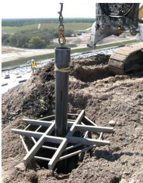
Slika 33. Postavljanje sonde i polaganje šljunka
