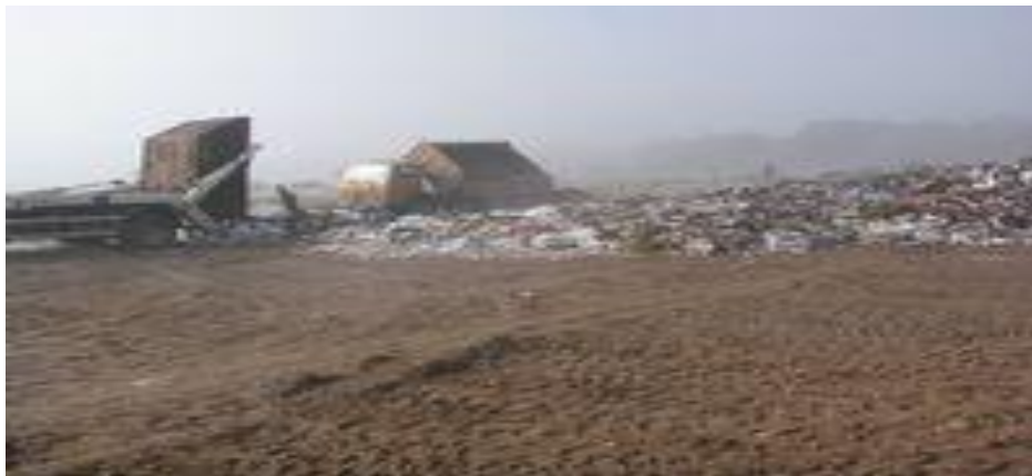
Slika 4. Deponija delimično prekrivena zemljom
