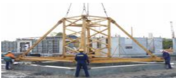
Слика 5. Непокретна база - база техником сидрења [3]
