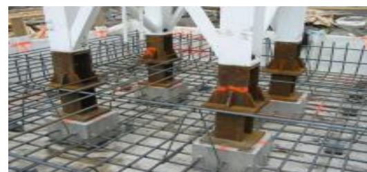
Слика 5. Непокретна база - база техником сидрења [3]
