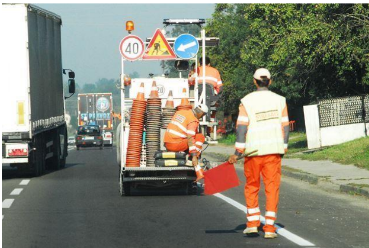
Слика 9. Регулисање саобраћаја на деоници пута на којој се изводе радови [19]
