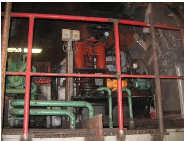
Слика 28. Дупли лежај вентилаторског млина
