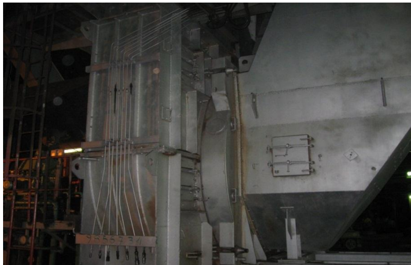
Слика 23. Кућиште вентилаторског млина
