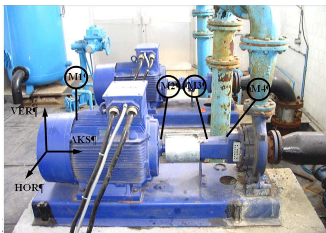
Слика 9.9.1.1 - Оцена вибромеханичког стања пумпног постројења према стандарду ISO 2372 [5]
