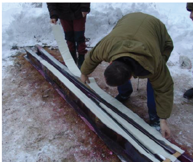
Слика 17. Постављање експлозива на метал [1]
