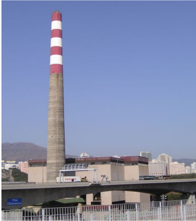
Слика 3.2.2. Постројење за спаљивање отпада (powerlab.fsb.hr, приступљено 27.5.2018.)
