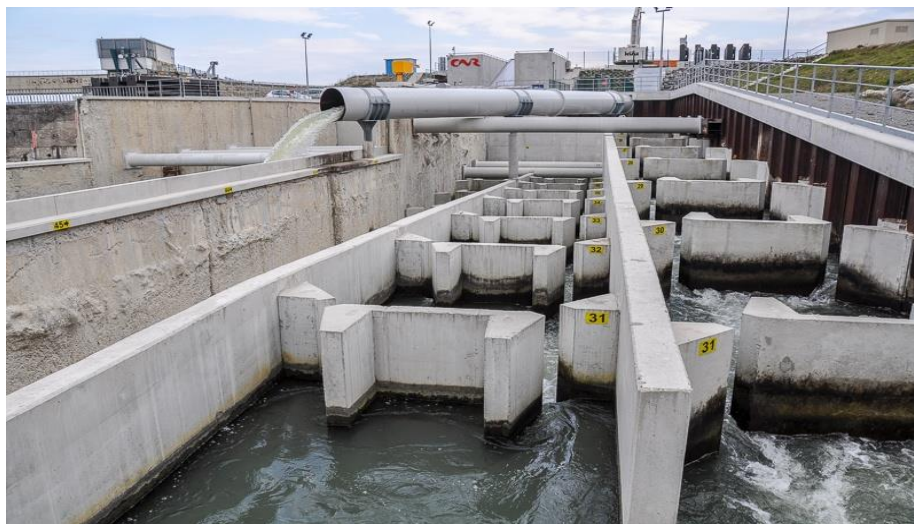
Слика 14. Изглед пролаза са вертикалним преградама на практичном примеру 7
