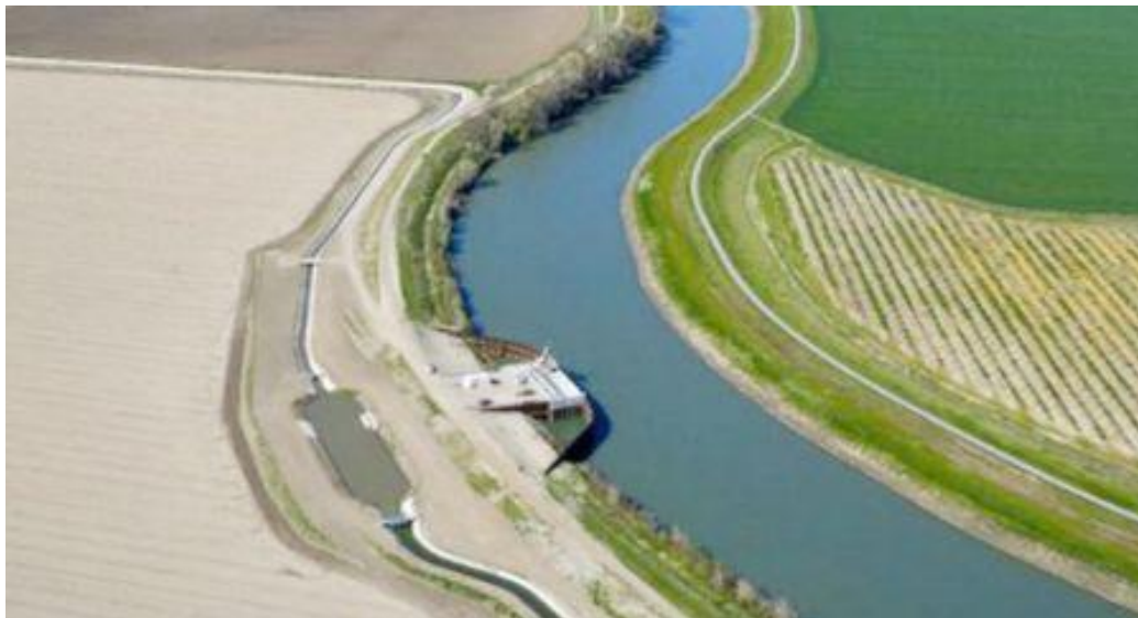
Слика 3. МХЕ на водоводним каналима 3
