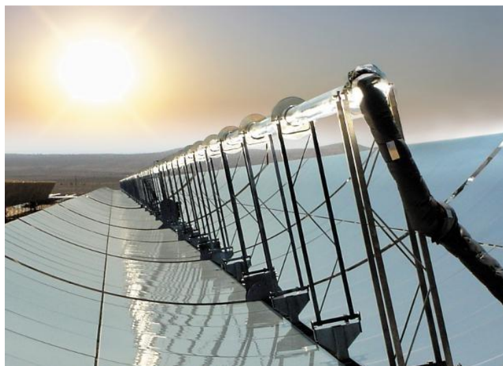
Слика 11. Соларна електрана са параболичним огледалима
