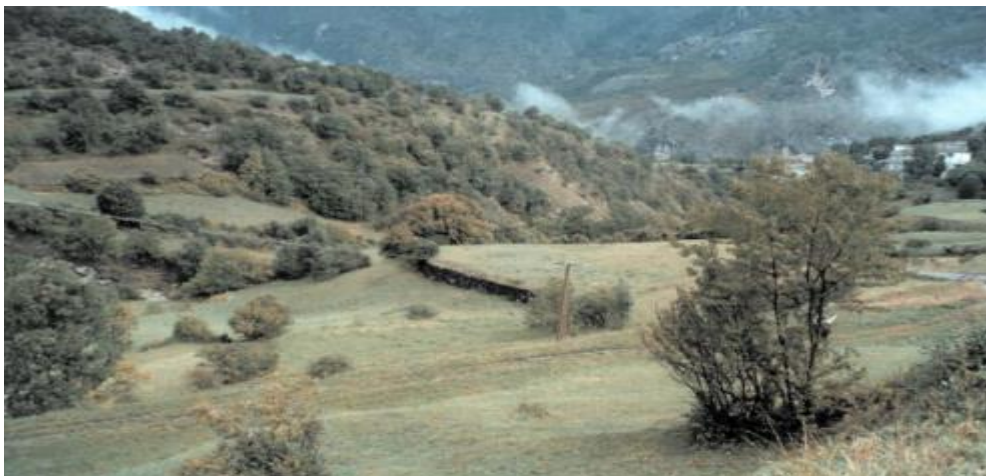
Слика 23. Коначан изглед канала након завршетка градње
