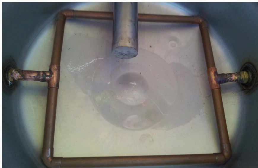
Слика 3.1.1.1.3 - Уграђен механички филтер квадратне структуре
