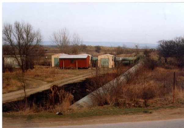
Слика 3.2.6. Преливна пумпна станица и одводни челични цевовод Ø 1400 mm
