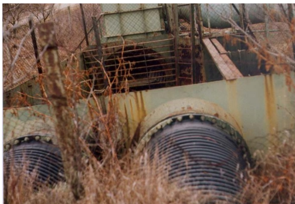
Слика 3.2.5. Изглед разделног резервоара са доводним (2*1200 mm) и одводним цевоводом Ø 1400 mm
