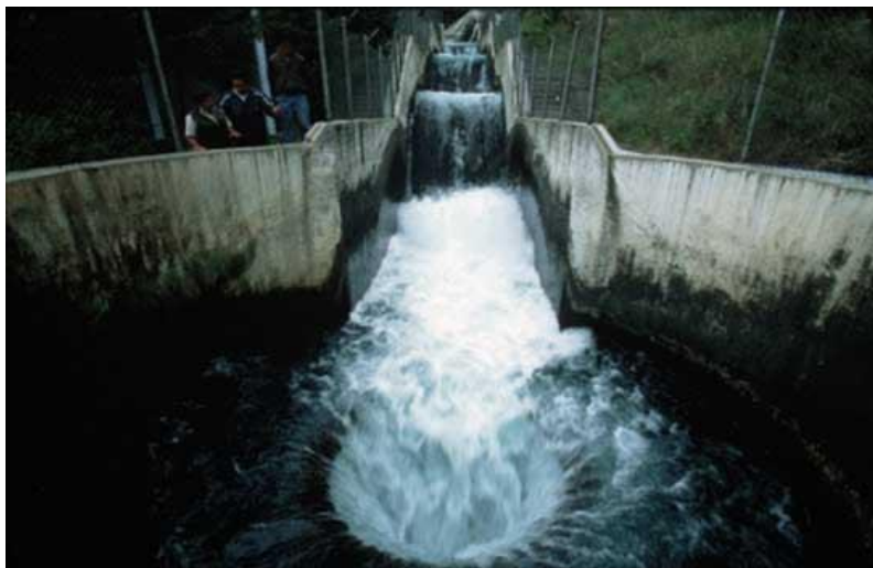
Слика 2. Канал за одвод воде
