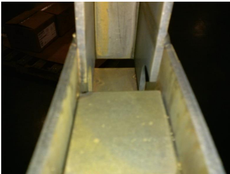
Слика 23 Дефекти израде –Оштри ћошкови и ивице
