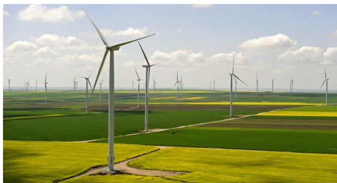
Слика бр. 20 – Изглед ветропарка
