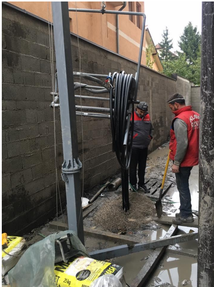
Слика 20. Уградња геотермалне сонде са туцаником, дубина 125 метара. [20]
