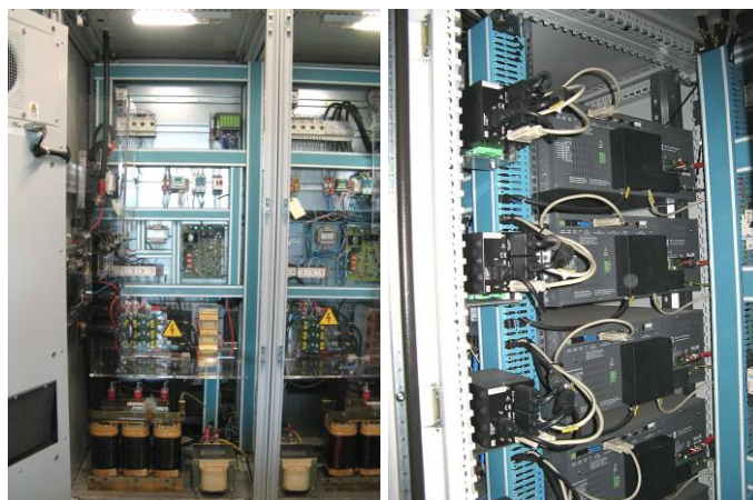
Слика 3.30. Електрична инсталација постројења за електрохемијску обраду [36]
