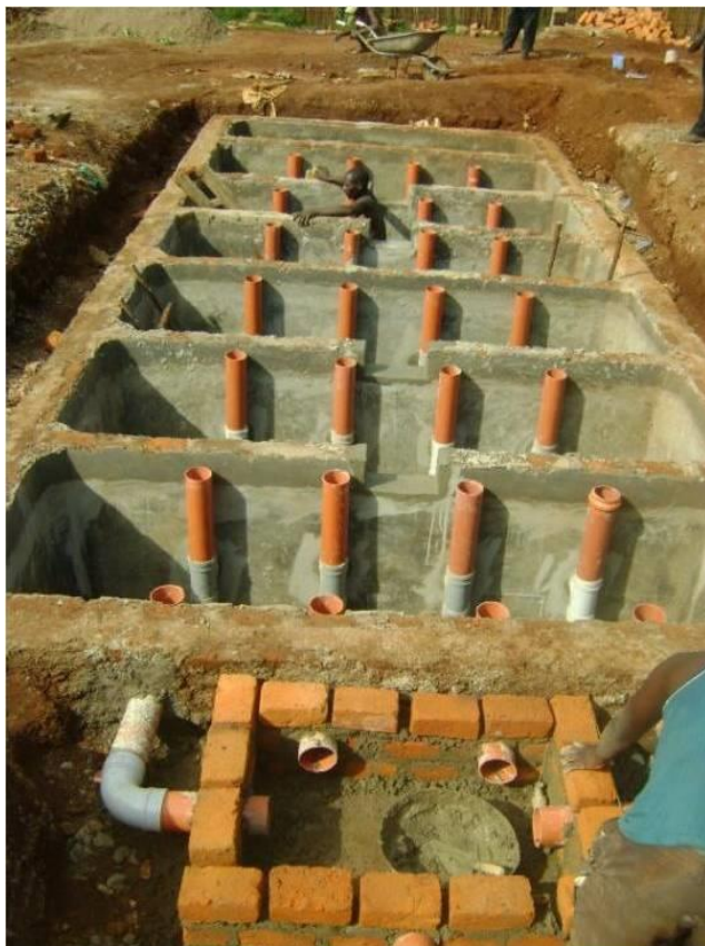
Слика бр. 13 – Приказ постављања ABR постројења [33]
