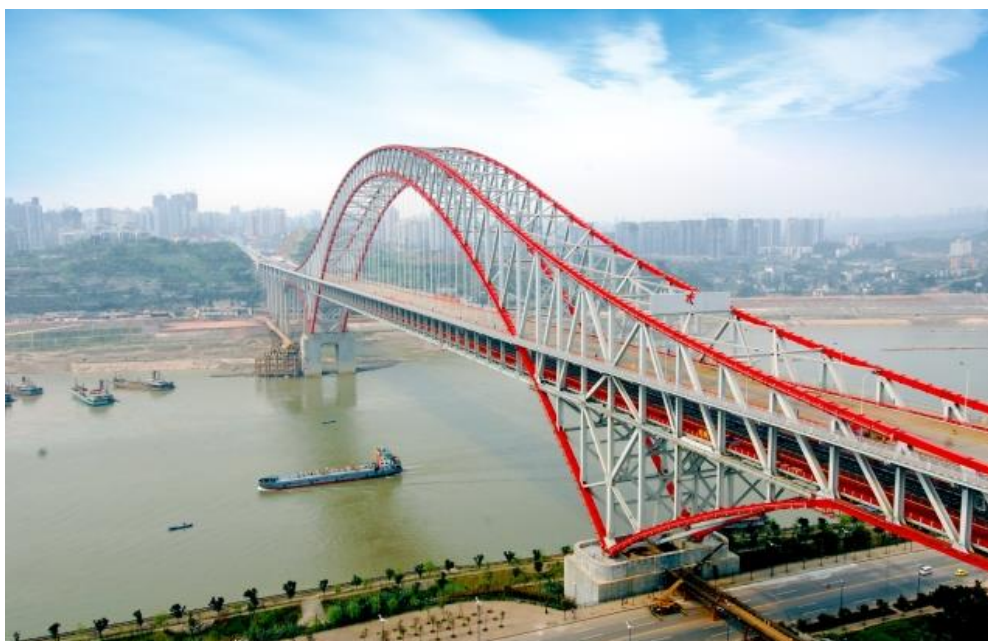
Слика 2.4. Чаотианмен мост у Чонгкингу са распоном од 552 метара је сада највећи мост са лучним распоном на свету
