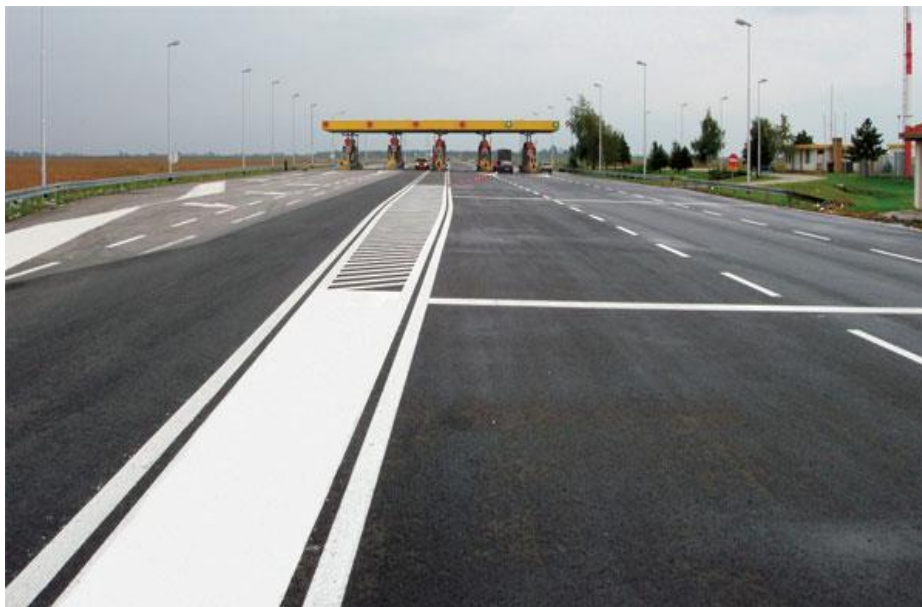
Слика 9. Хоризонтална сигнализација [30]
