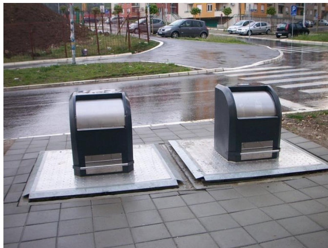
Слика 2.3- Систем уличних подземних контејнера
