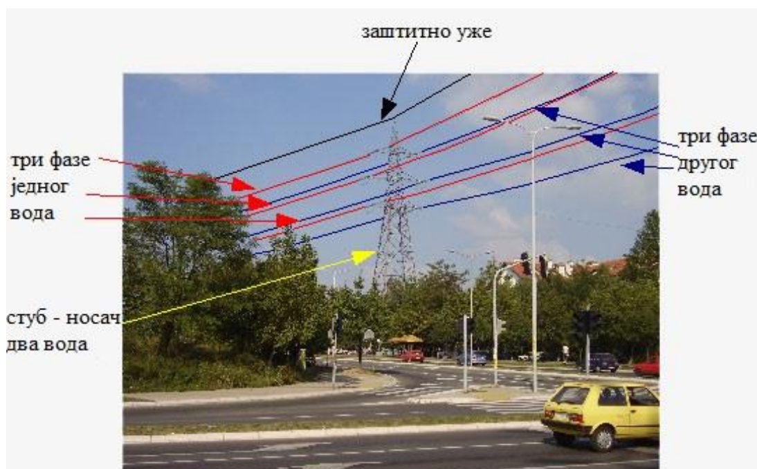
Слика 51. Далековод са стубом који носи два енергетска вода (црвени и плави) који су заштићени једним заштитним ужетом (црно) [16]
