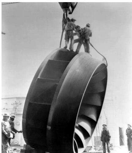
Слика 10. Монтажа радног кола [5]
