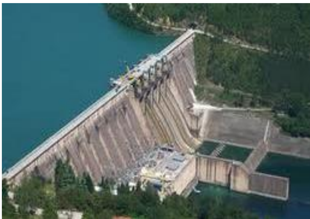
Слика 3. Акумулациона хидроелектрана у Бајној Башти [10]
