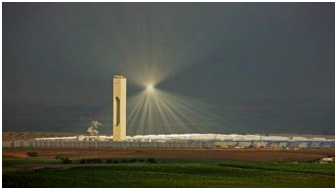
Слика 54 Жариште хелиостата одмакнуто од соларног сабирника
