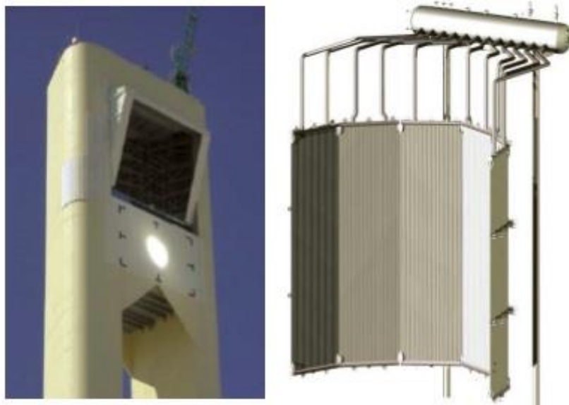
Слика 49 Сабирник смештен у шупљем кућишту торња.
