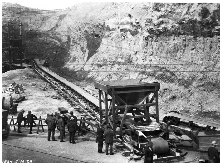
Слика 1.3. Тракасти транспортер за преношење руде 1795.године [3]
