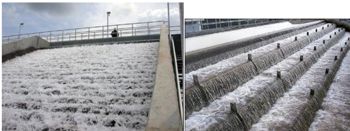
Слика 11.2.Аерација помоћу каскада
