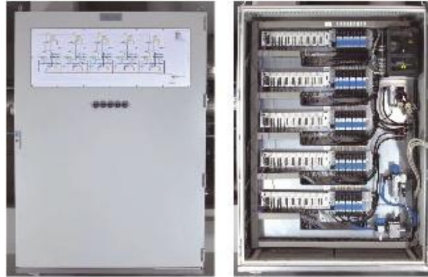
Слика 12.4. Управљачки ормар са дисплејем 46
