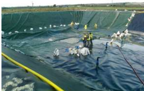
Слика 6. Аеробна лагуна - монтажа
