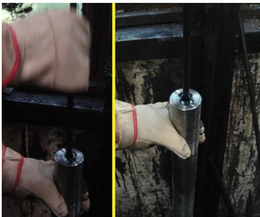
Слика 7.7. Поступак распоређивања масти шипком по обиму целе дужине цеви
