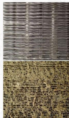
Слика 80. Чишћење кондензатора (пре и после)
