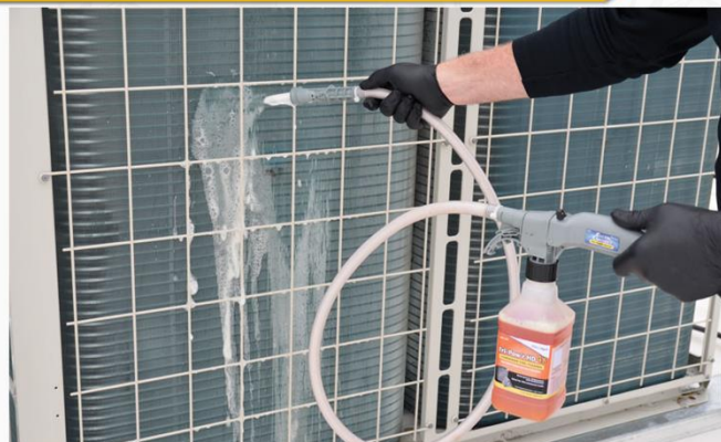
Слика 80. Чишћење кондензатора (пре и после)
