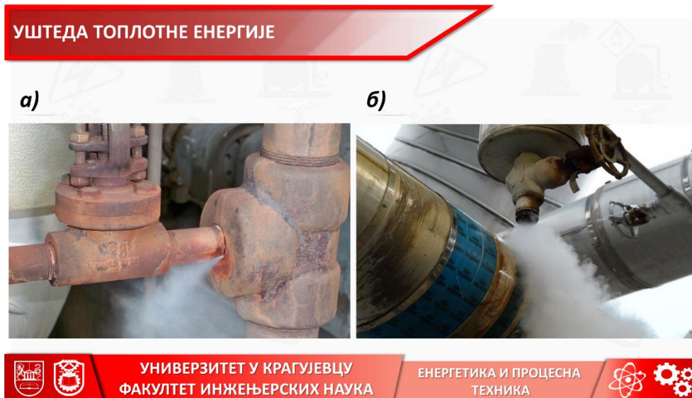
Слика 59. Цурење паре а) услед лошег контакта на саставима, б) услед лошег затварања вентила [102]
