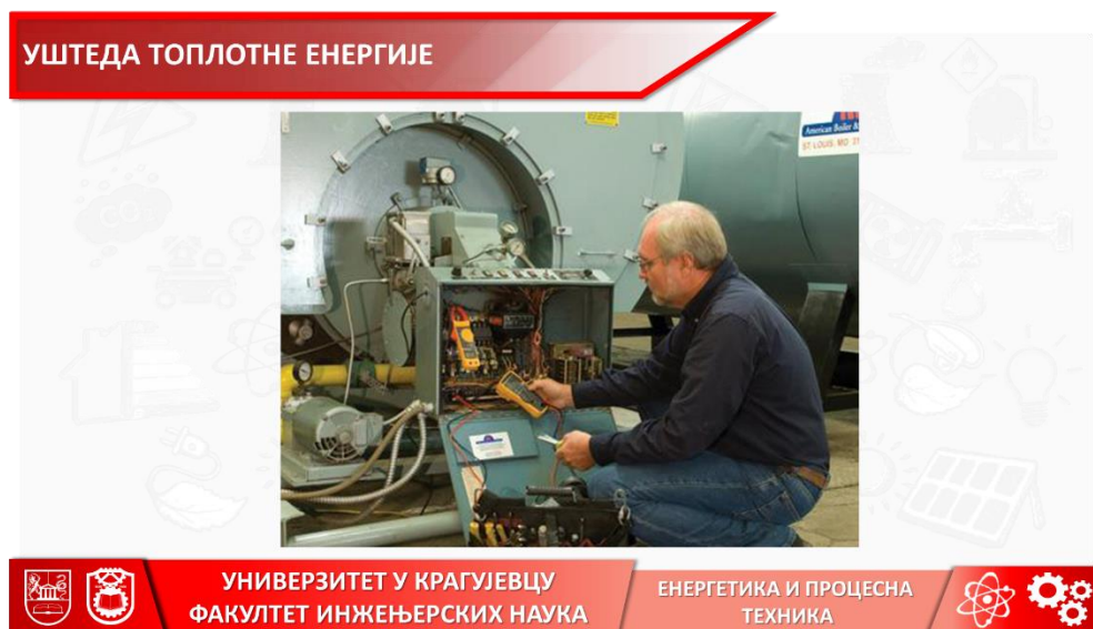
Слика 45. Провера исправности горионика [97]
