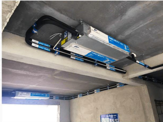
Слика 79. Правилно изоловане цеви расхладног система [108]
