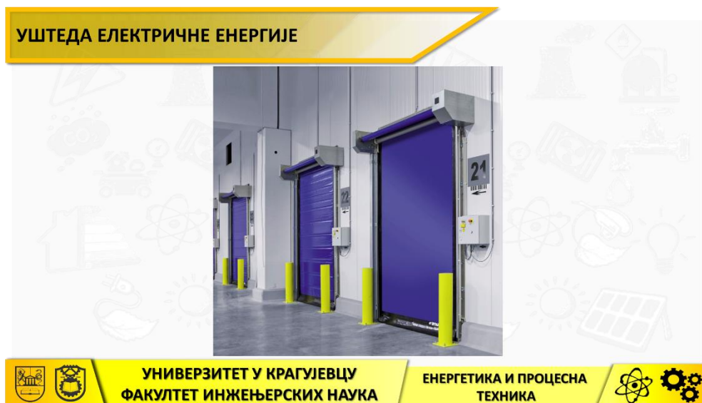
Слика 76. Аутоматска рол-врата за просторије хладног складиштења [106]
