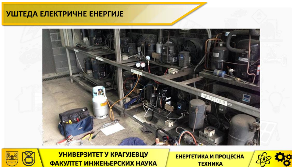
Слика 78. Процес пуњења расхладних система [107]
