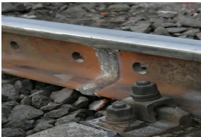
Слика 6.10 Метални шав добијен термитним заваривањем железничке/трамвајске шине
