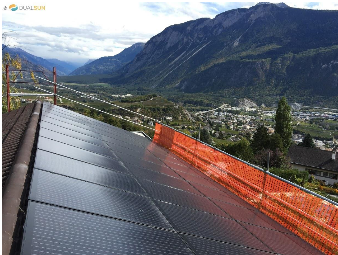
Слика 19. Приказ постављених хибридниx соларних пријемника на крову објекта [15]
