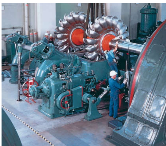
Слика 2.13 Коло Пелтонове турбине
