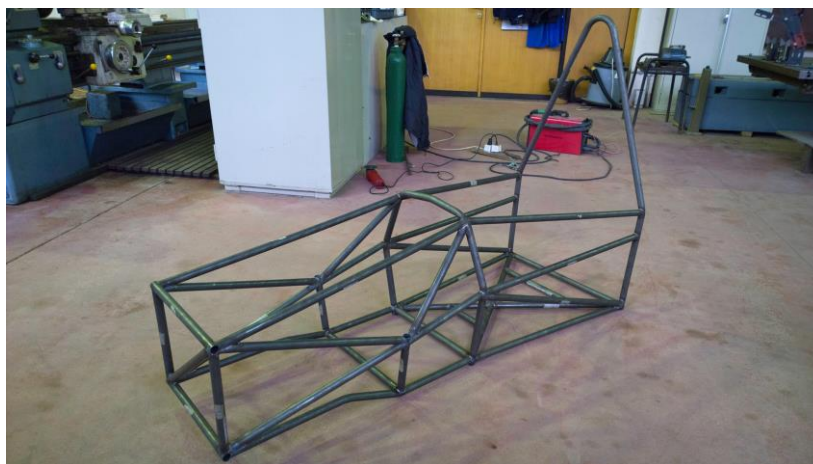
Слика 7.28 Процес монтаже
