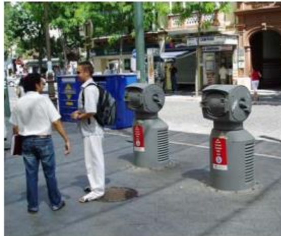
Слика 2.30. Специјално дизајниране посуде за одлагање отпада у вакуумском систему
