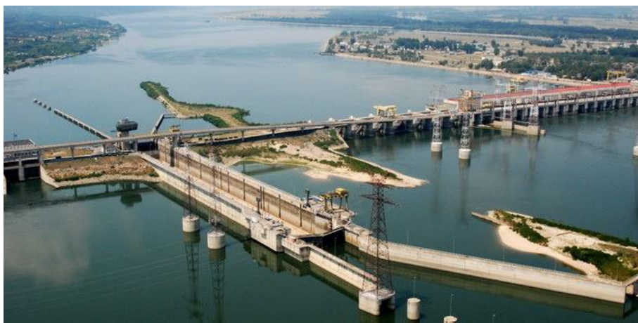
Слика 29. Спољашњи изглед ХЕ „Ђердап 1“ [25]
