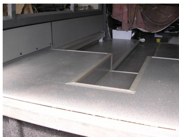
Слика 37. Изглед завршеног пода
