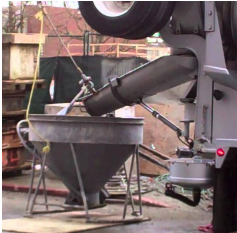
Слика 3.6. Пуњење кофе за бетон [7]
