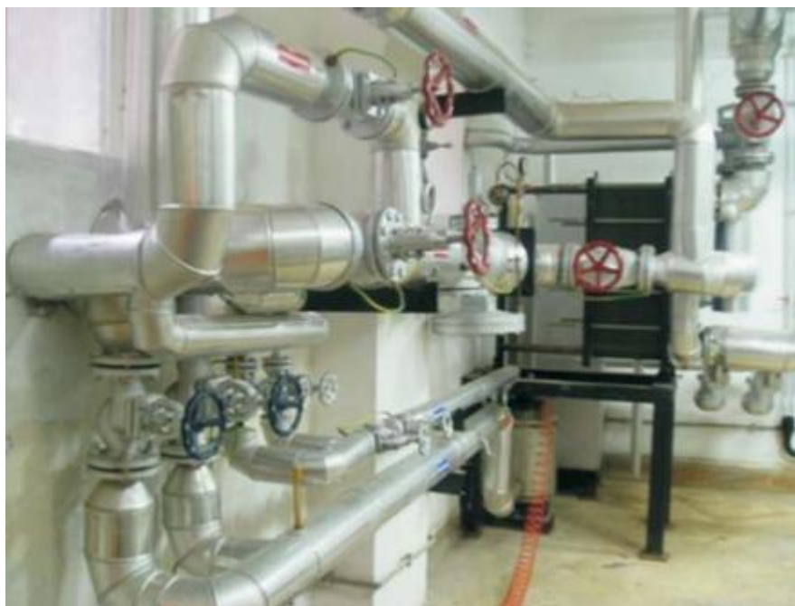
Слика 17. Плочасти размењивач топлоте у инсталацијама грејања објекта [15]
