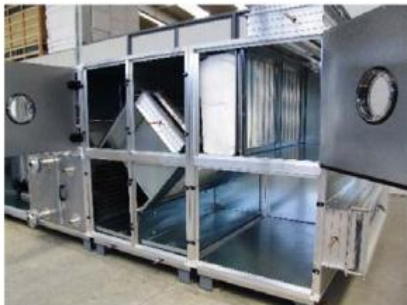
Слика 27. Плочасти рекуператор у клима комори [19]
