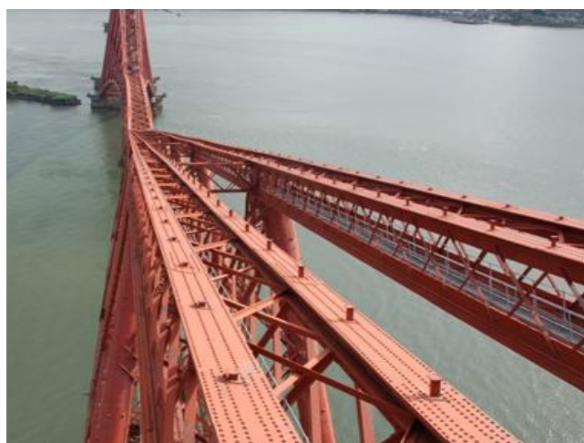
Слика 1.3. „The Forth bridge“ - приказ конструктивних елеменат и начин остваривања везе [1]
