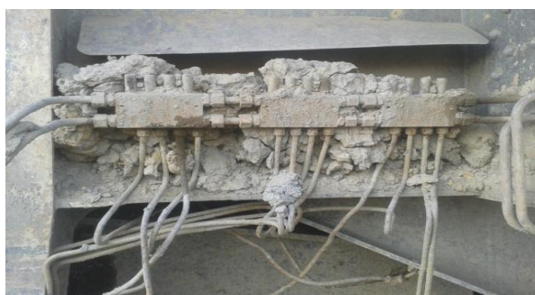
Слика 4.13. Низ распоредника на транспорту багера
