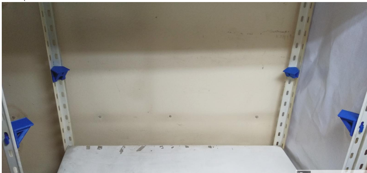
Слика 3. Монтирани носачи
