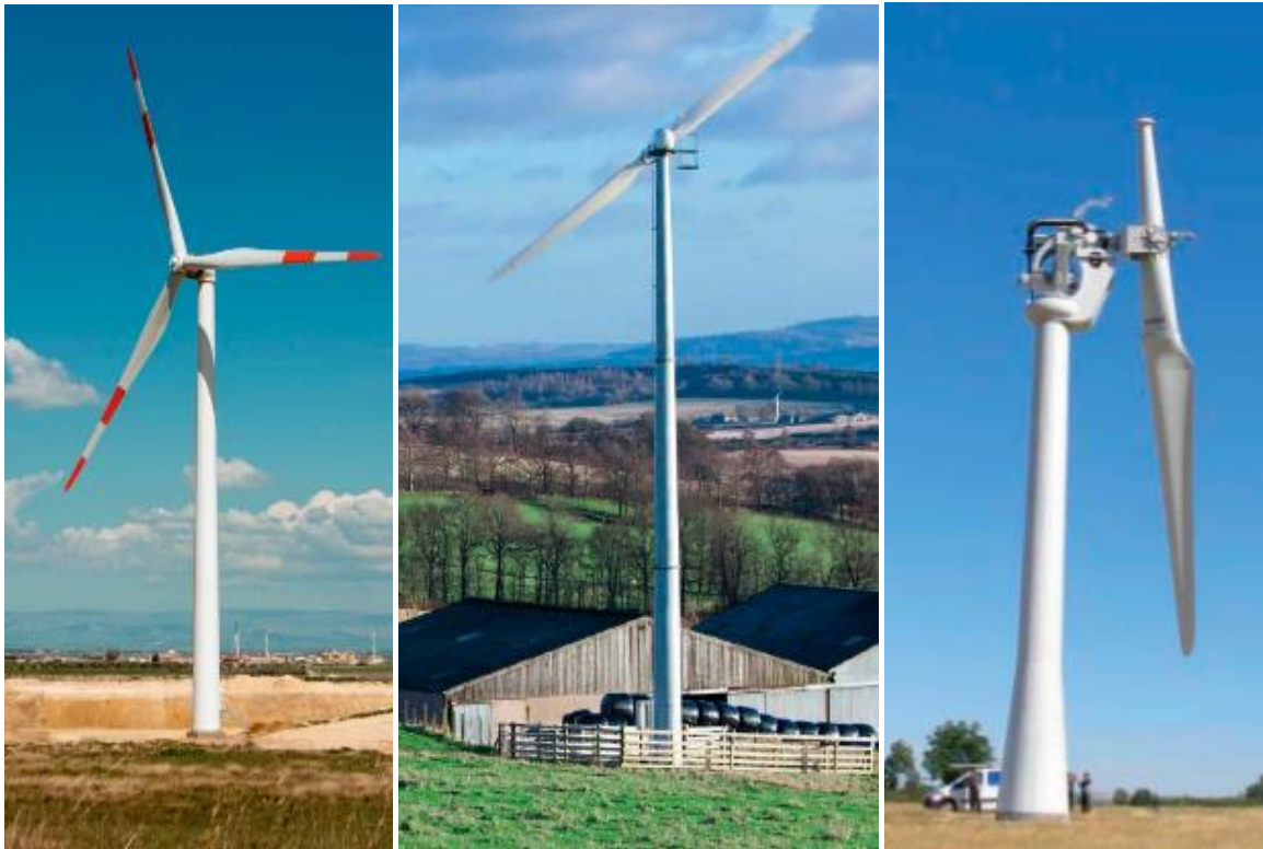
Слика 2.4. Хоризонтални ветрогенератори са три лопатице (лево), две лопатице (середина) и једном лопатицом (десно)
