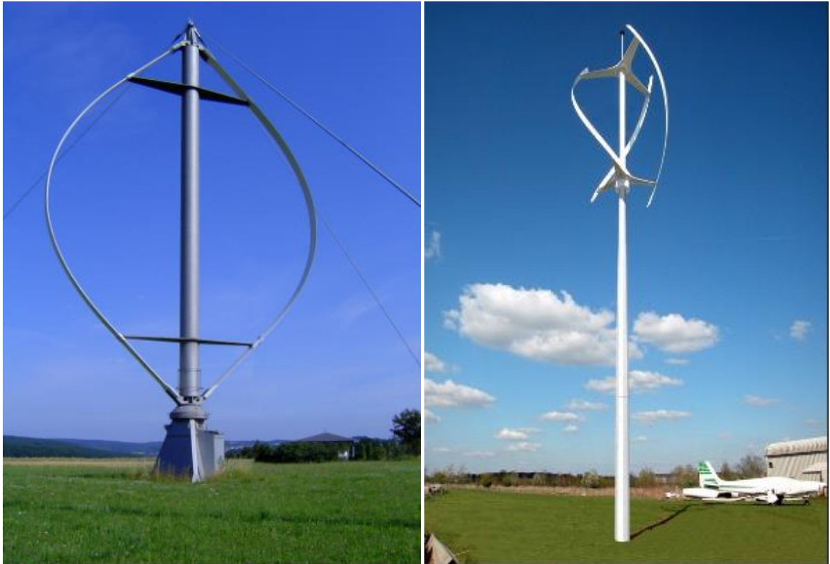
Слика 2.3. Конструкцијска извођења Dargieus-овог (лево) и Savonius-овог (десно) ветрогенератора
