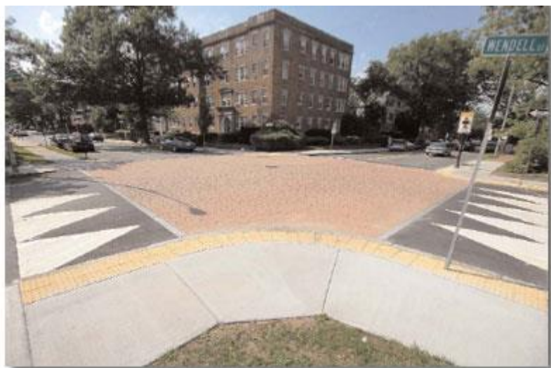
Слика 13. Пример издигнуте раскрснице [11]
