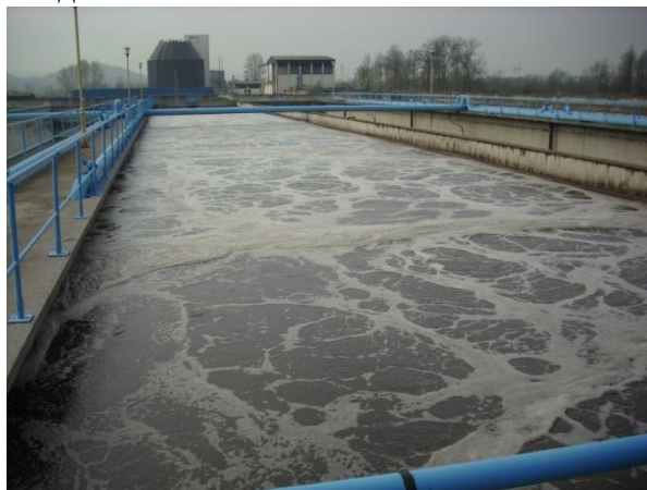
Слика 2.2.1.3 Биоаерациони базен
