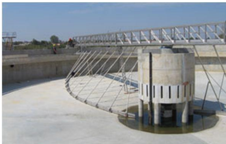
Слика 2.2.1.2 Згртач муља и пливајућих супстанци у испразњеном примарном таложнику [7]
