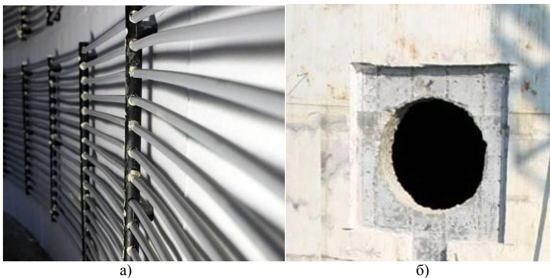
слика 6.2.1 а) топоводне цеви у унутрашњости дигестора; б) топлотна изолација од стиропора на бетонском дигестору у фази израде [10]
