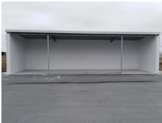
Слика 6. Објекат привременог складиште у изградњи
