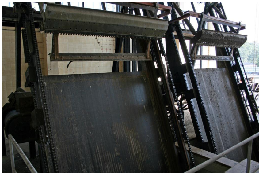
Слика 6. Приказ решетки за механичко пречишћавање (коса аутоматска решетка) [15]
