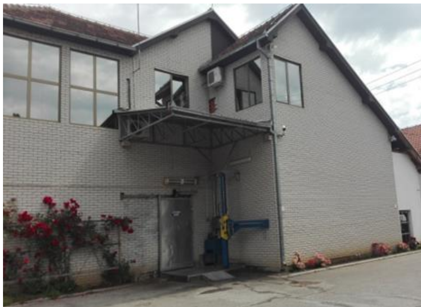
Слика 43. Изглед објекта кланице Будућност
