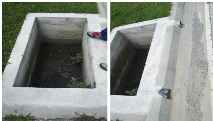
Слика 33. Таложник за пречишћавање кишнице
