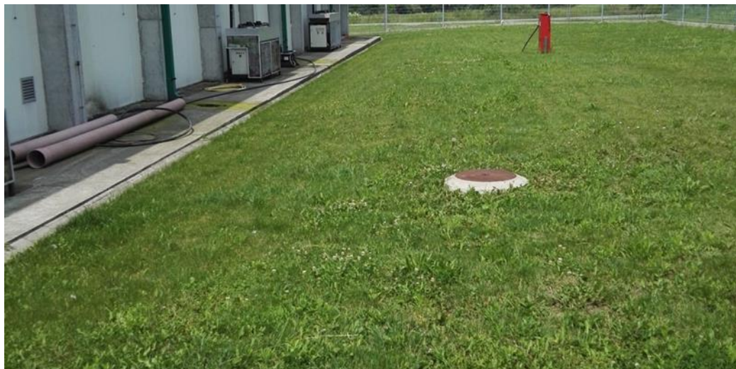
Слика 37. Јаме за индустријску воду
